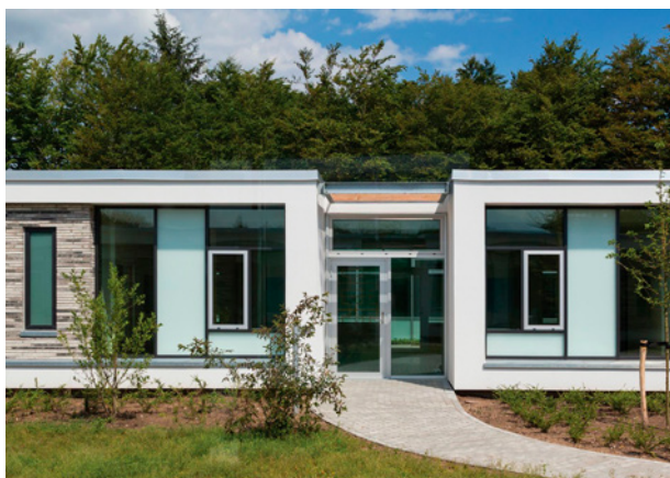
Esbjerg Psykiatriske afdeling. Et psykiatrisk hospital. Nybyggeri og ombygning.
