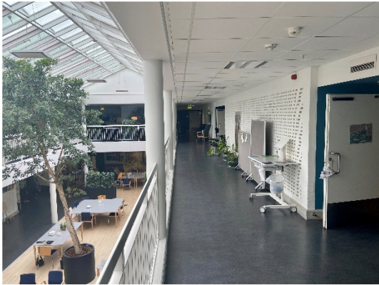
Billede 28. Gang ved fællesrum før
